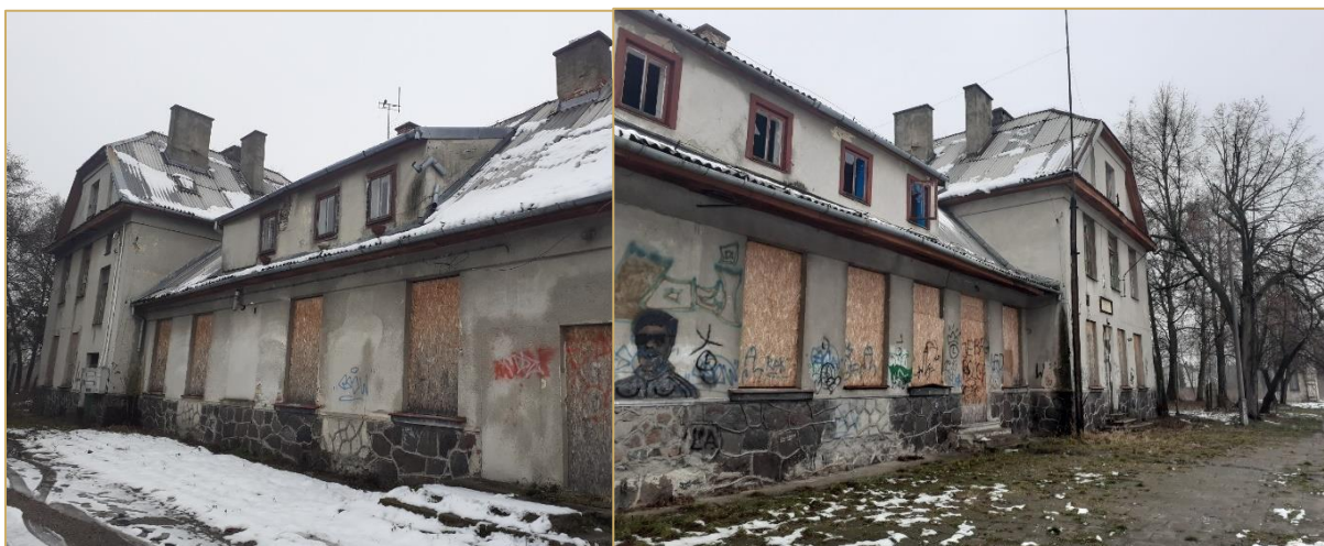
Rysunek 12. Obecny wygląd budynku dawnego dworca w Grójcu.
