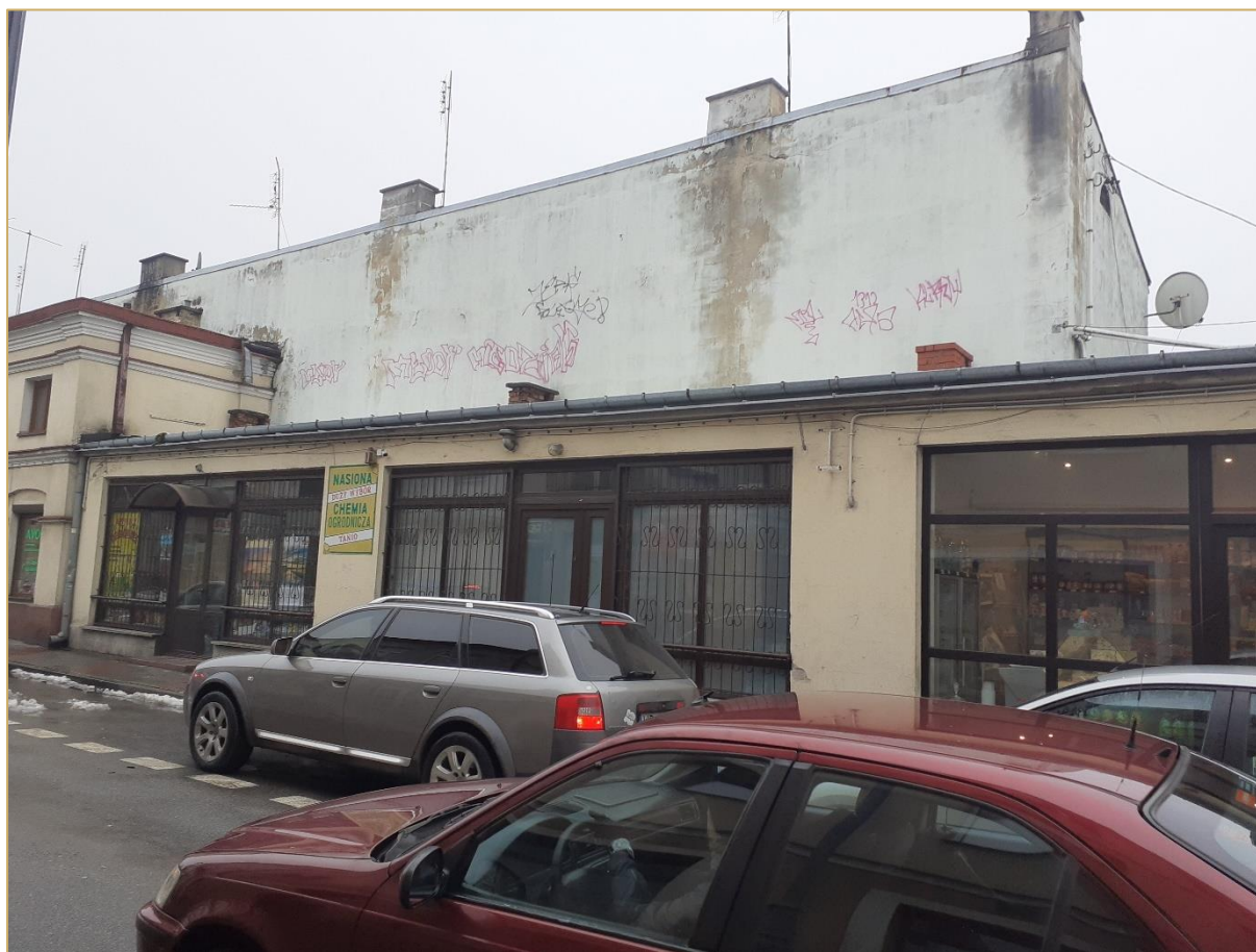
Rysunek 15. Zabytkowe jatki murowane zlokalizowane przy ul. Jatkowej w Grójcu.
